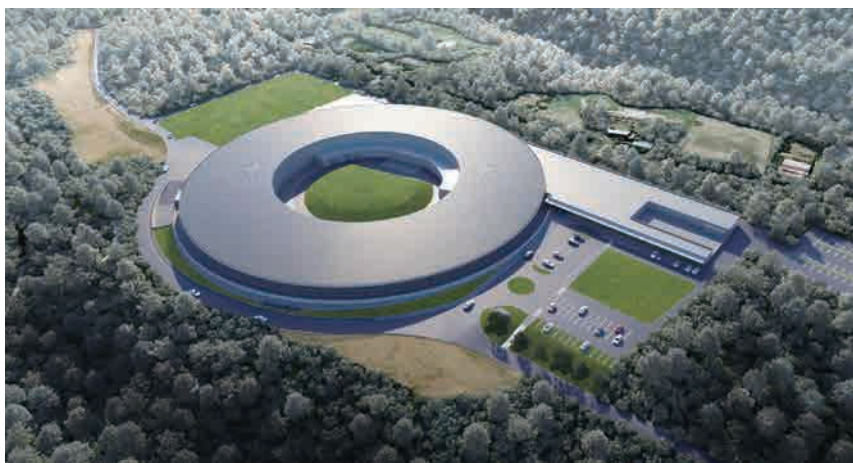
図1. 東北大学青葉山新キャンパス内に建設が進む次世代放射光施設（イメージ）
