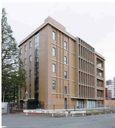
2019年度7月に完成した新棟「南2号館」
