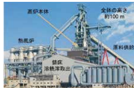
高炉全景(神戸製鋼所加古川第3高炉)
