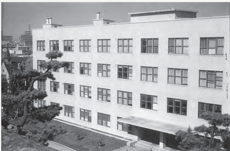
昭和35年当時の「非水研新館(後の非水研本館)」 — 新館は、工学部の応用化学科と化学工学科が青葉山に移転する 昭和42年秋まで、非水研と共同で使用していた。 —
