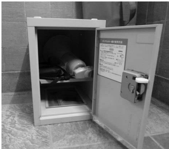
写真1 防災ボックス内部
